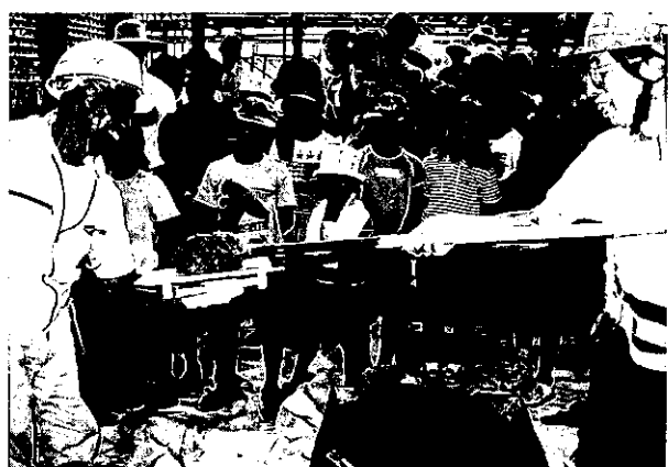
平成13年8月 土壁塗り
