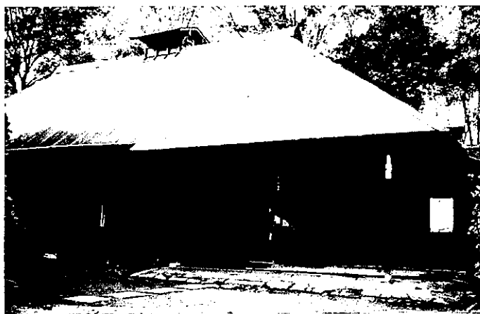
解体前 平成3年
